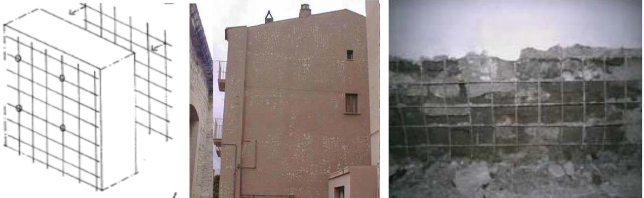
Se realizzato su pareti esterne dà adito a fenomeni di degrado ricorrenti come l'ossidazione dell'armatura metallica dovuta allo scarso spessore copriferro protettivo.
