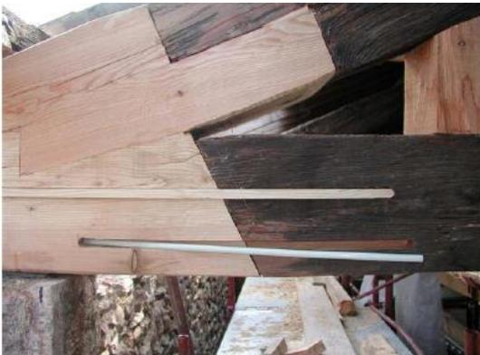
Sostituzione di parte lignea ammalorata con nuova "protesi", collegamento alla porzione originaria per mezzo di lamine di legno a tassello
