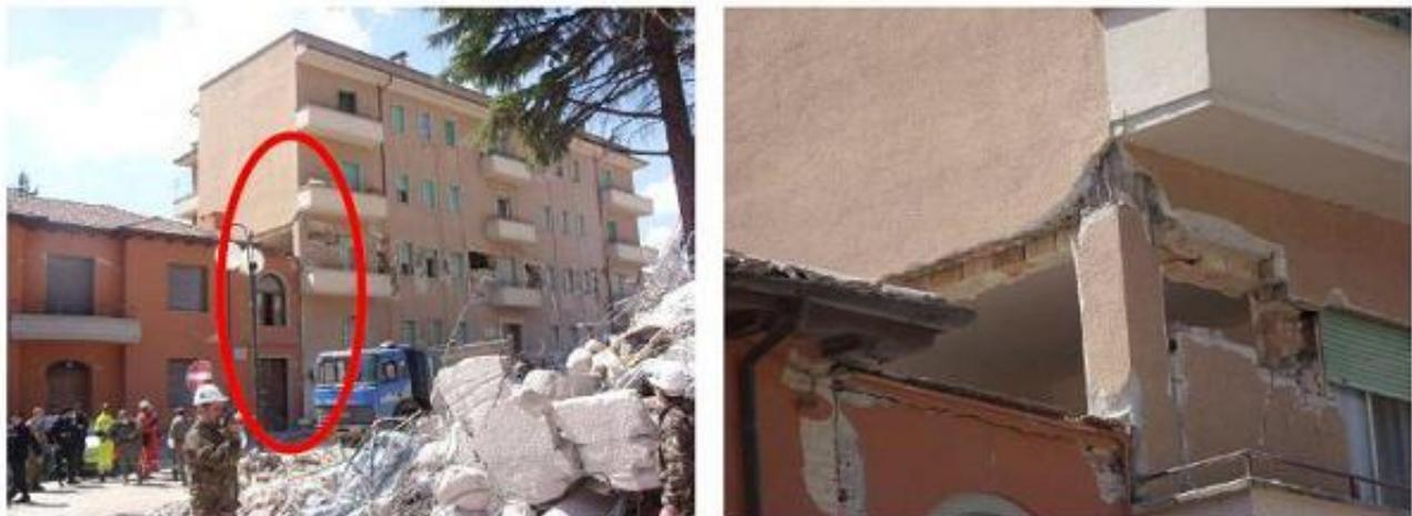
Contiguità di edifici con caratteristiche geometriche e strutturali differenti (fonte Decanini 2009)
