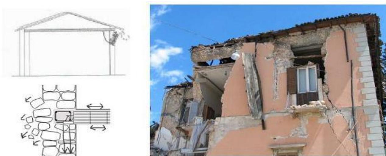
**Figura 14 – Abruzzo 2009 – Danneggiamento di muratura in presenza di cordoli in c.a. (fonte: Governare il rischio 2012)**
